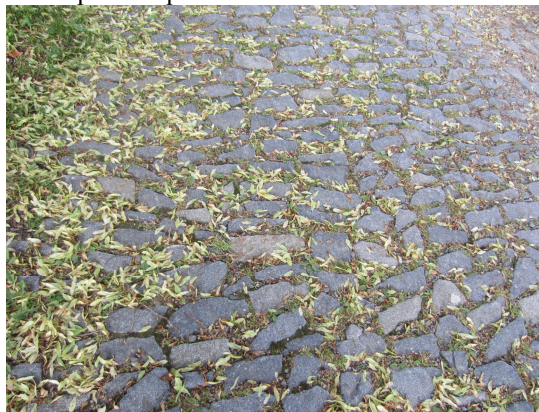
nepravidelná kamenná dlažba
